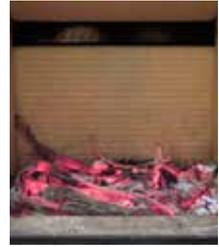
6. Plaats 2-3 houtblokken van ongeveer 0,7-1 kg en met een lengte van 30-50 cm in één laag over de sintels, gescheiden met ongeveer 1 cm. De beste verbranding wordt verkregen als de blokken in de lengte ongeveer evenwijdig aan de achterwand van de haard worden gelegd.
