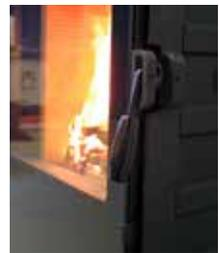
4. Wanneer u (na 5-10 min.) ziet dat de schoorsteen warm genoeg is om te trekken, sluit u het deurtje. Als aan alle voorwaarden is voldaan, vormt er zich na nog eens 15-20 min. een dikke gloeiende laag in de verbrandingskamer.
