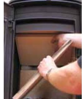
3. Kantel de tweede zijplaat en verwijder deze.
