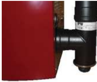
Fig. 79 - Reiniging rookleiding
