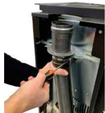
Fig. 42 - Vastzetten met buisklem
