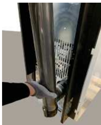
Fig. 41 - Buis met diam. 80 mm aansluiten
