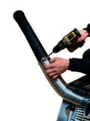
Fig. 67 - Buis met diam. 80 mm aansluiten
