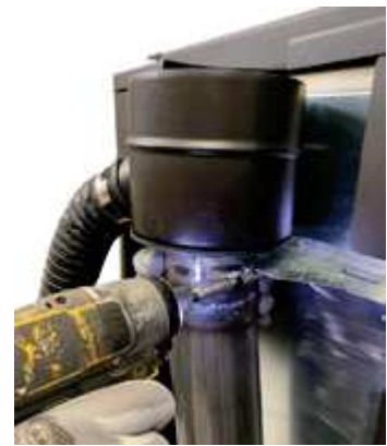
Fig. 48 - Vastzetten met buisklem
