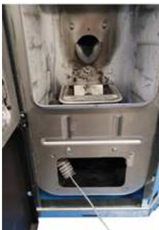
Fig. 82 - Reinig met pijpenwisser
