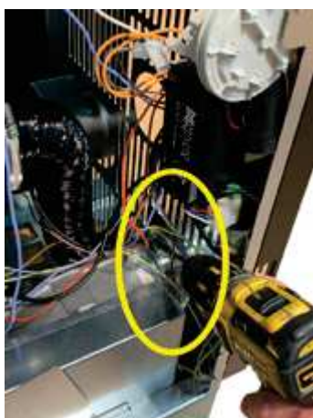
Fig. 66 - Flexibele buis vastzetten
