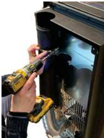
Fig. 69 - Buis met diam. 80 mm vastzetten
